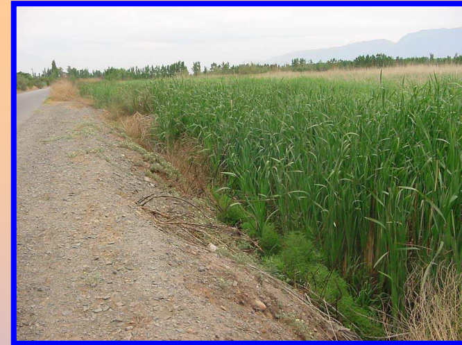
Fig. N° 2: Dren con falta de mantenimiento
