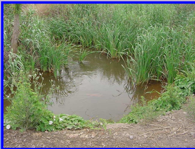
Fig. N° 3: Dren con agua estancada.
