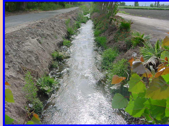
Fig. Nº 6: Dren Sen buenas condiciones de limpieza y funcionamiento .
